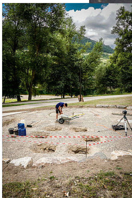
Réalisation des ancrages
